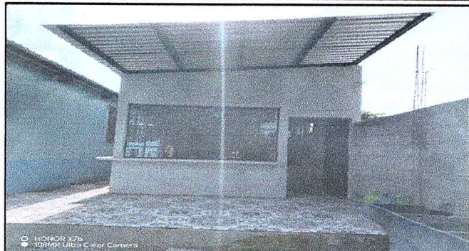
Foto 2: LA NUEVA COCINA QUE FUE REMOZADO POR LA OTRA QUE SE VIÓ OBLIGADO REALIZAR SUS MEJORAS PARA QUE SE LLEVE UN MEJOR TRABAJO PARA EL BENEFICIO DE LOS ESTUDIANTES
