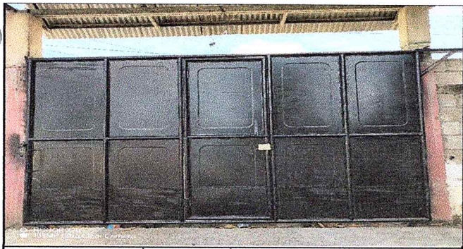
Foto 5: LA REPARACIÓN DEL PORTÓN PRINCIPAL DEL ESTABLECIMIENTO QUEDA TOTALMENTE MEJORADA CAMBIANDO PARTE DE LAS LÁMINAS Y LA SUSTITUCIÓN DE NUEVOS RODOS.
