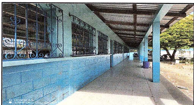
Foto 4: LAS VENTANAS DE LA ESCUELA QUEDAN ASEGURADAS CON LA INSTALACIÓN DE NUEVOS VALCONES EN LA PARTE FRONTAL DE LA ESCUELA.
