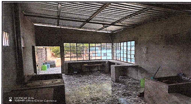
Foto 3: ASÍ QUEDA LA PARTE INTERIOR DE LA NUEVA COCINA PARA QUE LAS COCINERAS PUEDAN REALIZAR DE LA MEJOR MANERA SU TRABAJO Y UNA BIENA ATENCIÓN AL ESTUDIANTADO.
